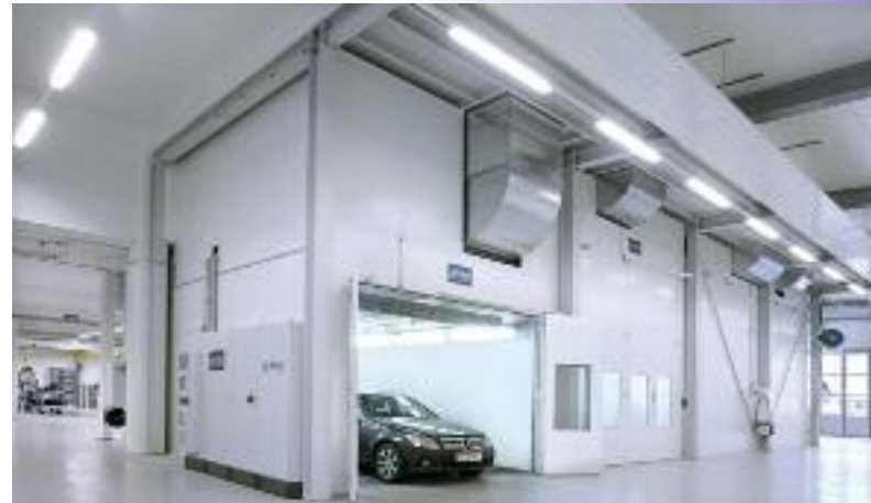
Lackierzentrum mit drei kombinierten Farbspritz- und Trockenkabinen für die Pkw- und Nutzfahrzeug-Lackierung.
